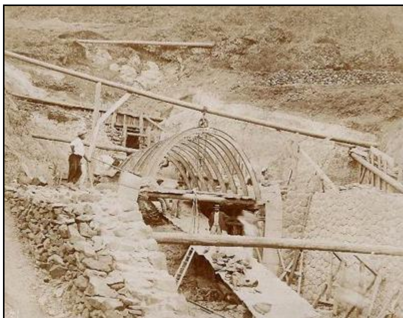
Ci-contre et ci-dessous, trois photos d'époque montrant la construction du fronton d'entrée du tunnel et les boisages mis en place pour soutenir la route qui passe juste au-dessus
