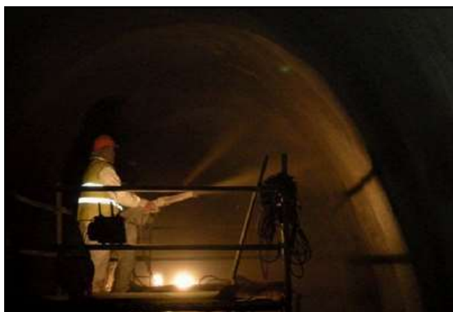
Projection du béton
