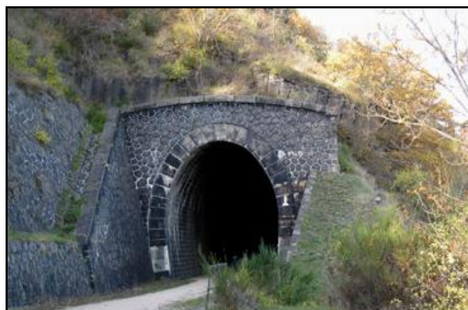
Deux vues de la sortie du tunnel
