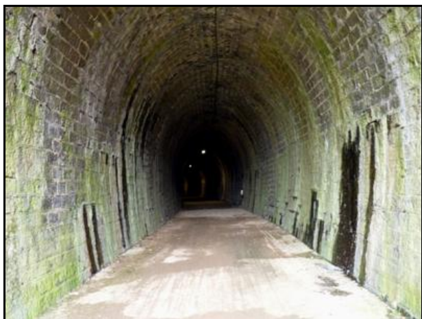
Le début de la galerie prise depuis l'entrée
