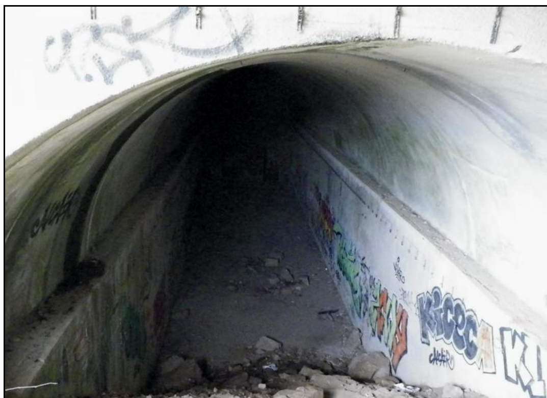
L'intérieur de la galerie, intact
