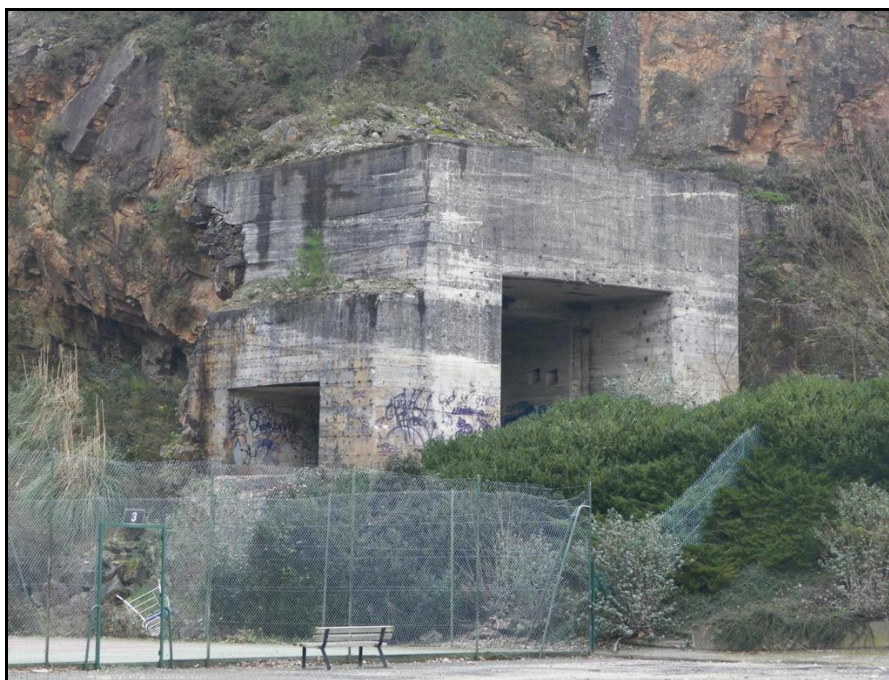
L'entrée fortifiée de l'ouvrage L'entrée ferroviaire est le grand orifice de droite
