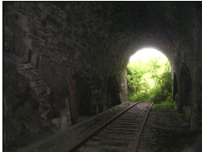
Ci-dessus et ci-dessous, la galerie du tunnel avec ses piédroits ajourés
