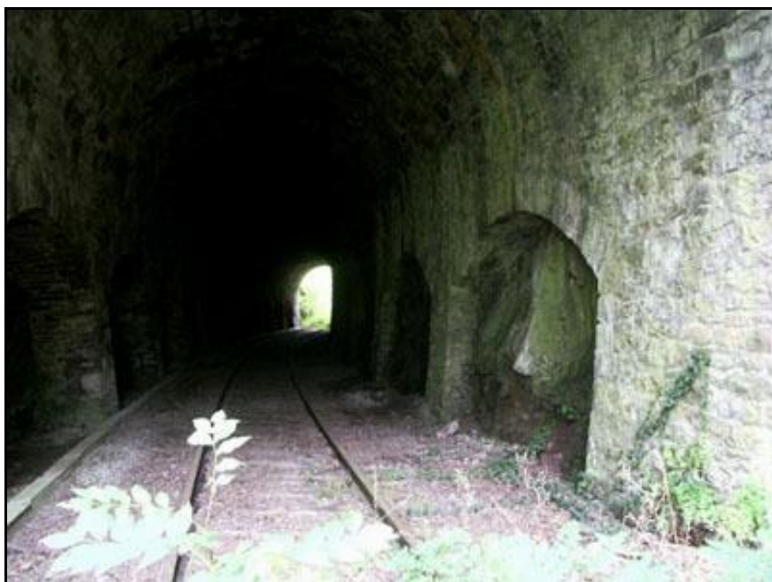
Ci-dessus et ci-dessous, la galerie du tunnel avec ses piédroits ajourés
