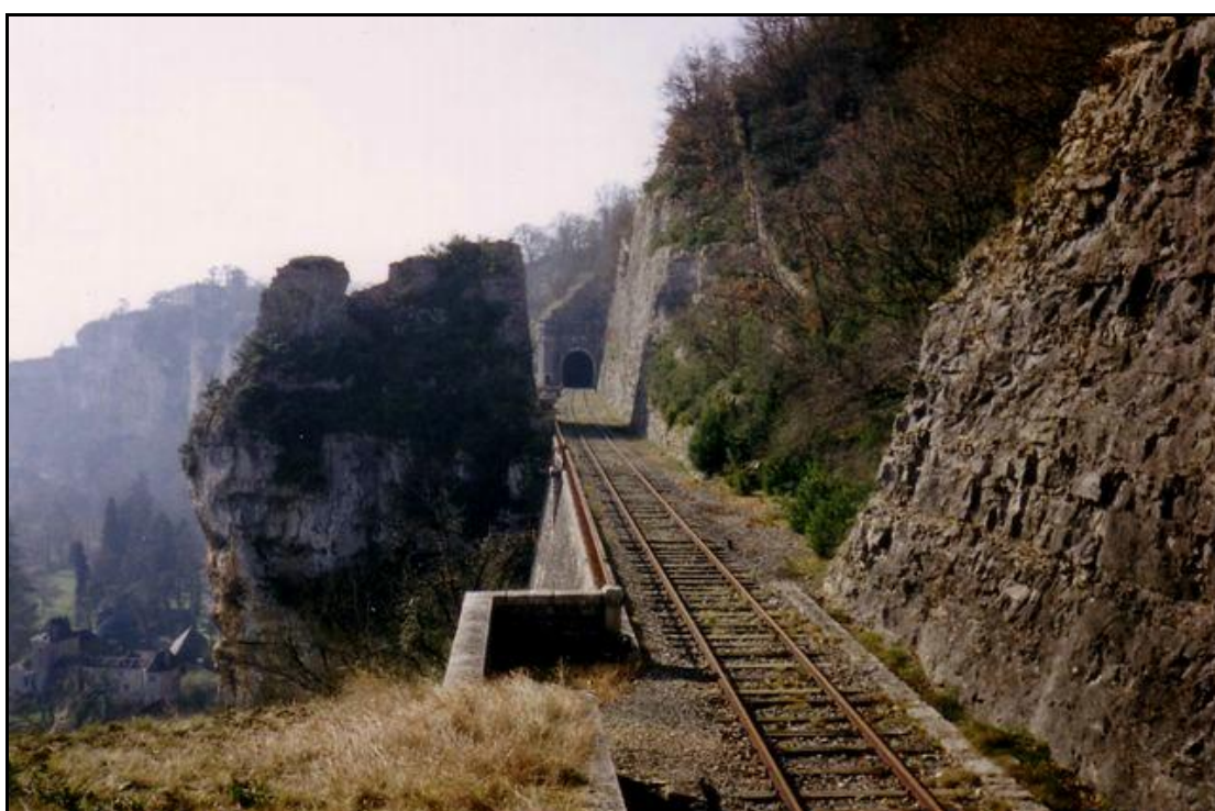
La voie dans la falaise et la sortie fortifiée du tunnel de Mirandol
