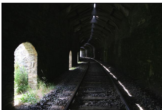
Contrairement aux autres galeries paraneige voisines, les plaques du toit ne sont pas jointives
