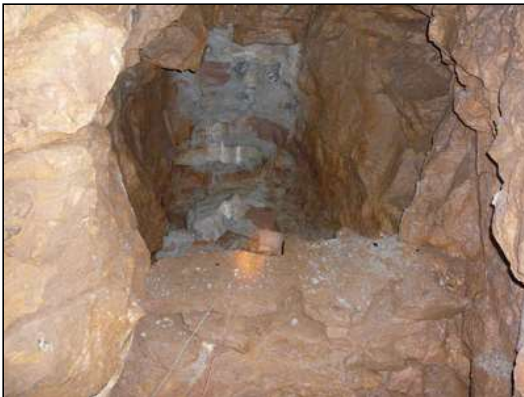
Petit muret et travaux de colmatage réalisés dans le fond de la résurgence
