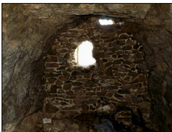
La sortie de la galerie vue de l'intérieur
