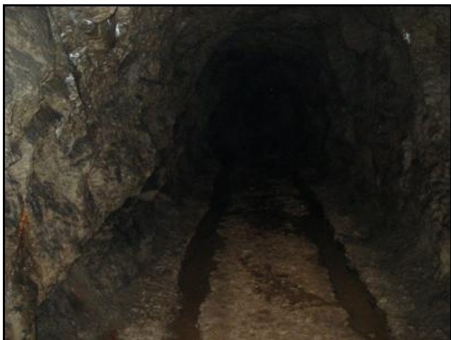
Les « rails » pour tombereaux, dans le sol de la galerie
