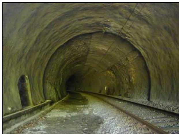
Les extrémités du tunnel ont été renforcées par des coques en béton, ce qui explique les ruptures de continuité que l'on peut voir au niveau de la voûte
