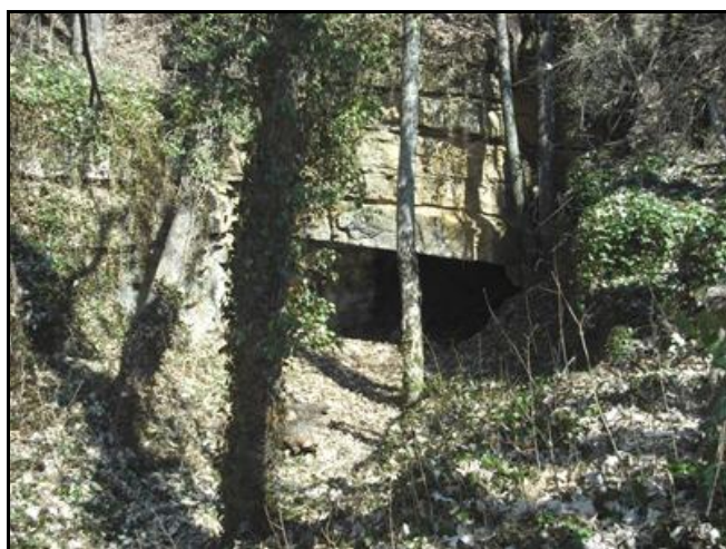
L'entrée et sa chatière d'accès
