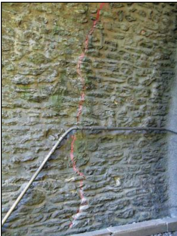
Fissure due aux mouvements de terrain
