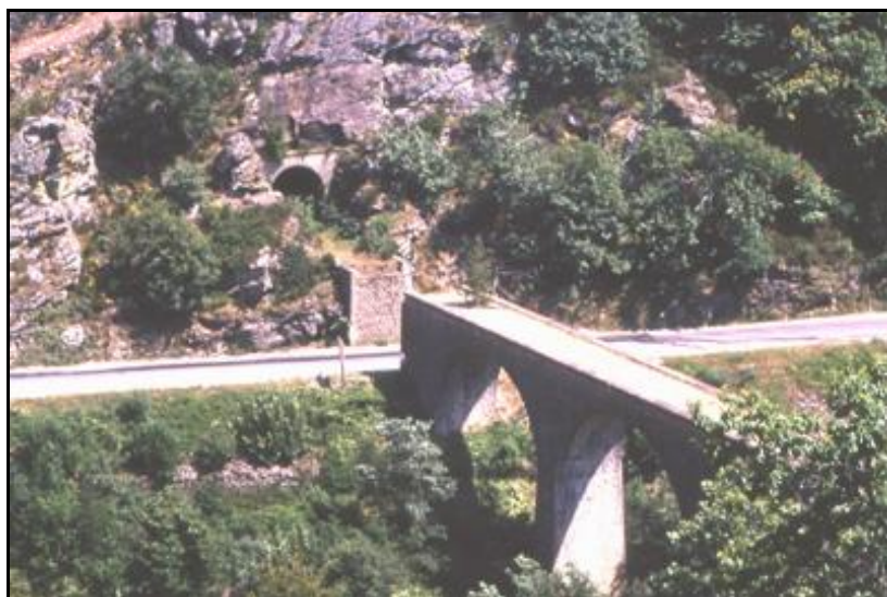
Le viaduc, peu de temps avant sa destruction
