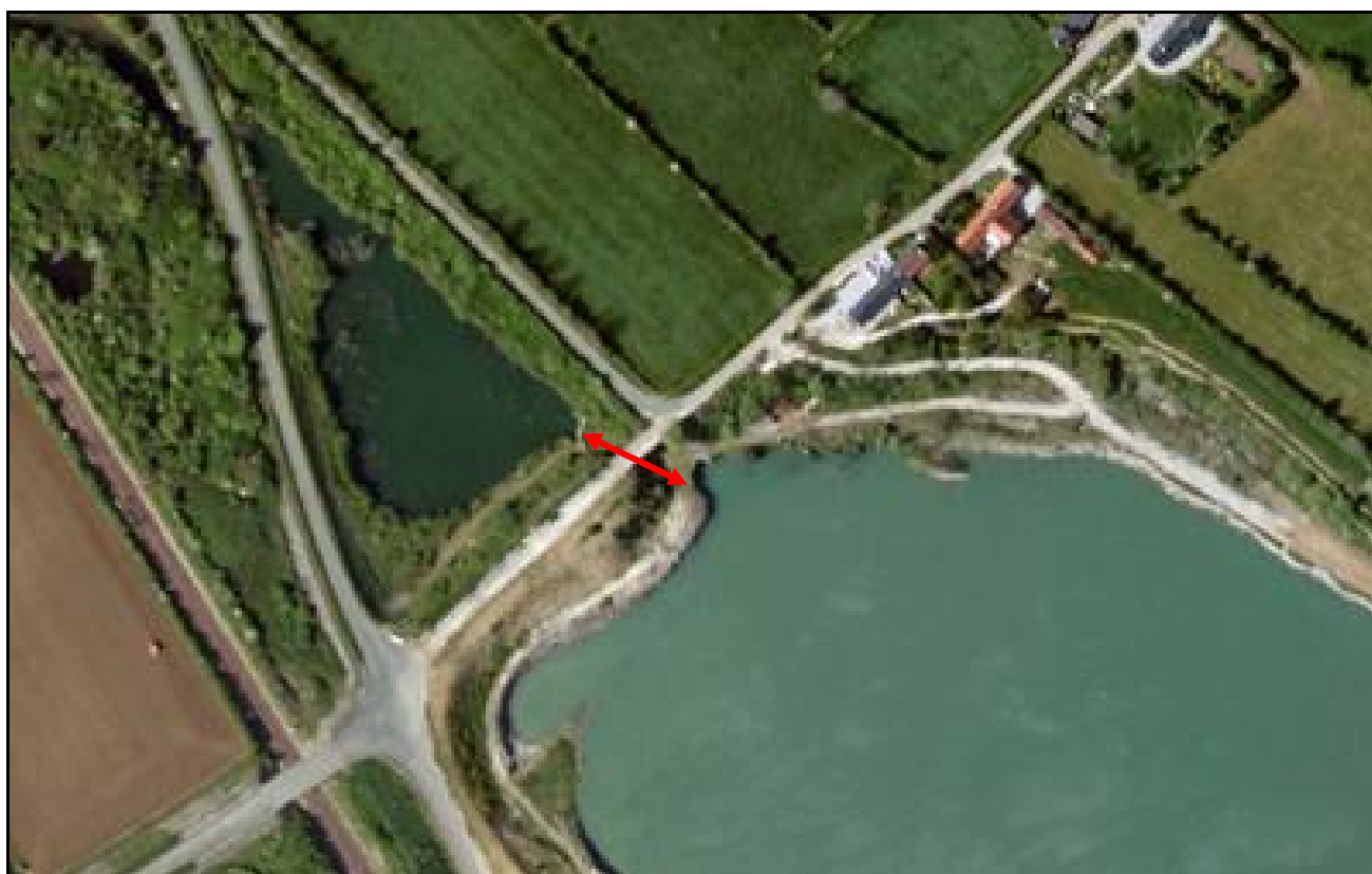
La carrière noyée avec les deux frontons du tunnel encore bien visibles
