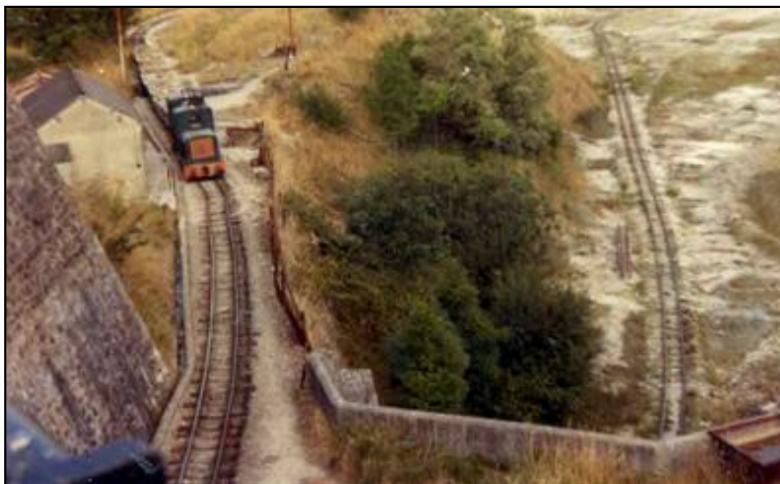
La nouvelle carrière de Goulet dans les années 1980 prise depuis le pont de la route D 269 A gauche, un train remonte la rampe de sortie de la carrière A droite, tout en bas, l'entrée du tunnel que domine le pont
