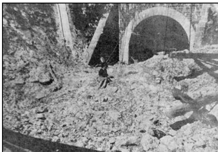
La sortie du tunnel après les bombardements
