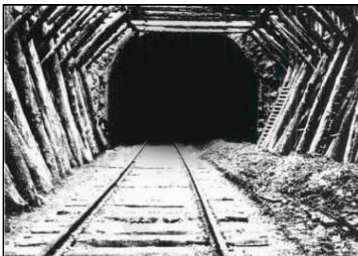
Boisage de soutènement effectué par les Allemands
