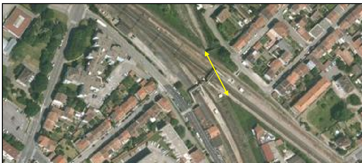
Vue aérienne de la galerie de Jarville
