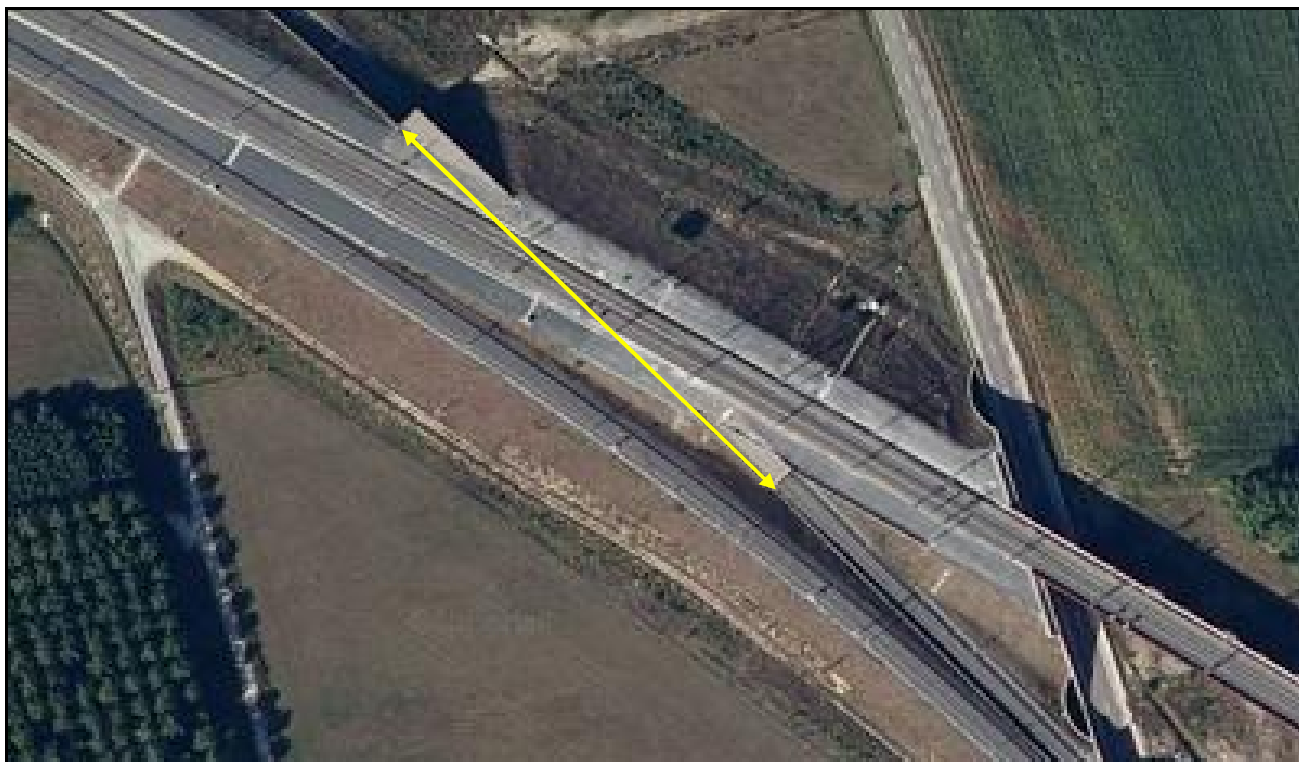
Vue aérienne de la galerie de Sous le Rèle LGV
