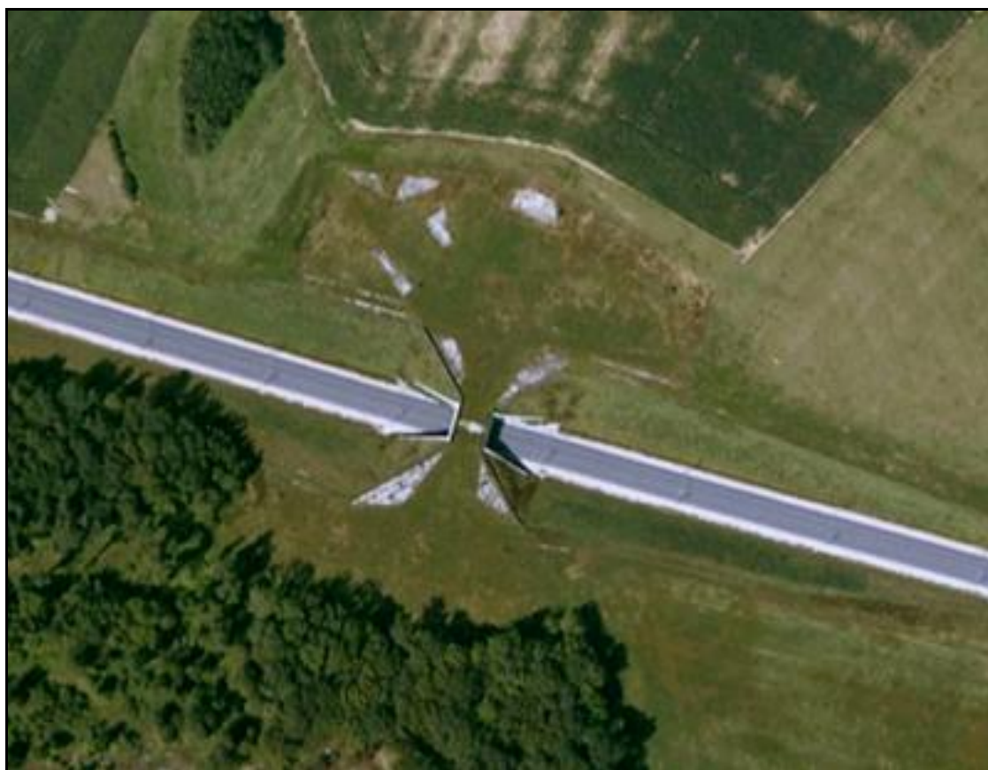
Vue aérienne du faux tunnel de Ragnée
