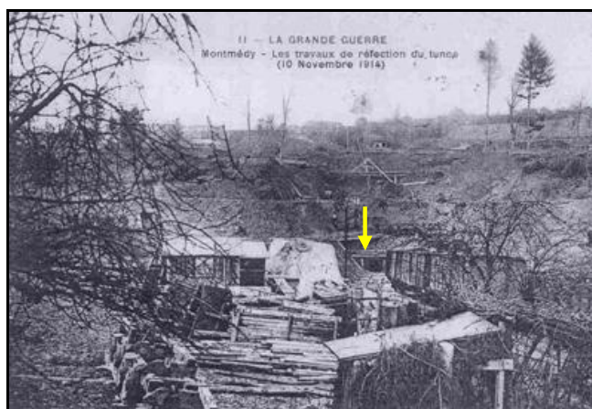
Côté entrée et côté sortie, les travaux de reconstruction entrepris par les Allemands La flèche jaune indique la petite galerie percée par les Allemands pour retrouver la galerie initiale
