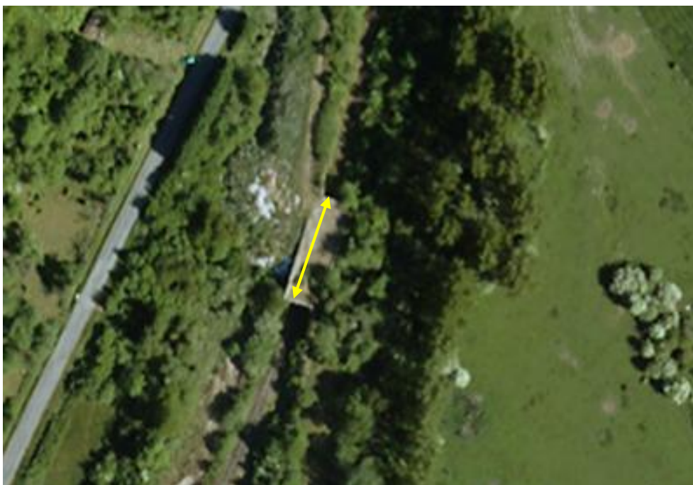
Vue aérienne de l'ancien saut de mouton de Sassey sur Meuse
