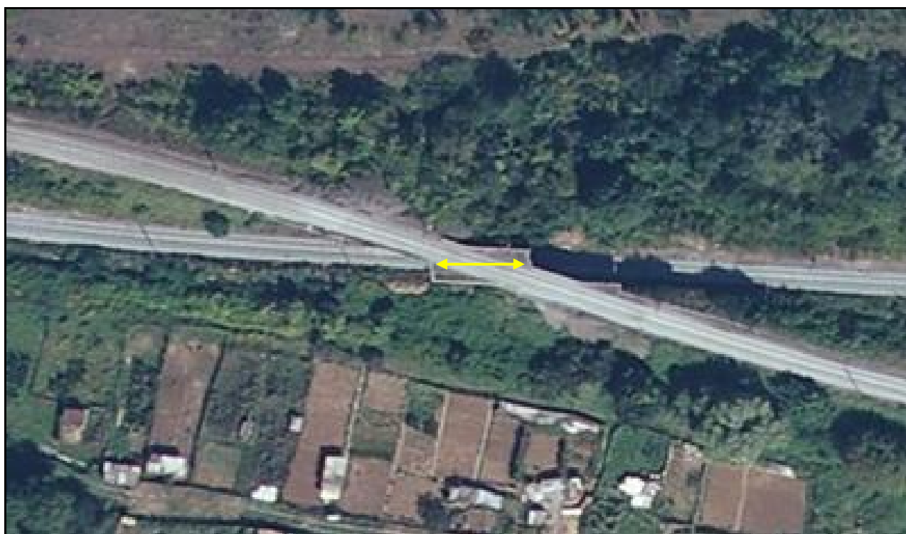
Vue aérienne du saut de mouton de Rombas
