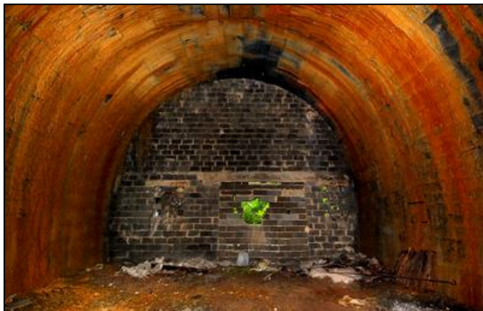
La sortie du tunnel vue de l'intérieur
