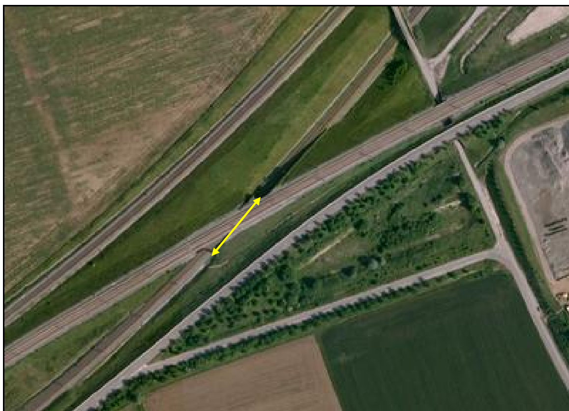
Vue aérienne de la galerie Fretin Sud LGV
