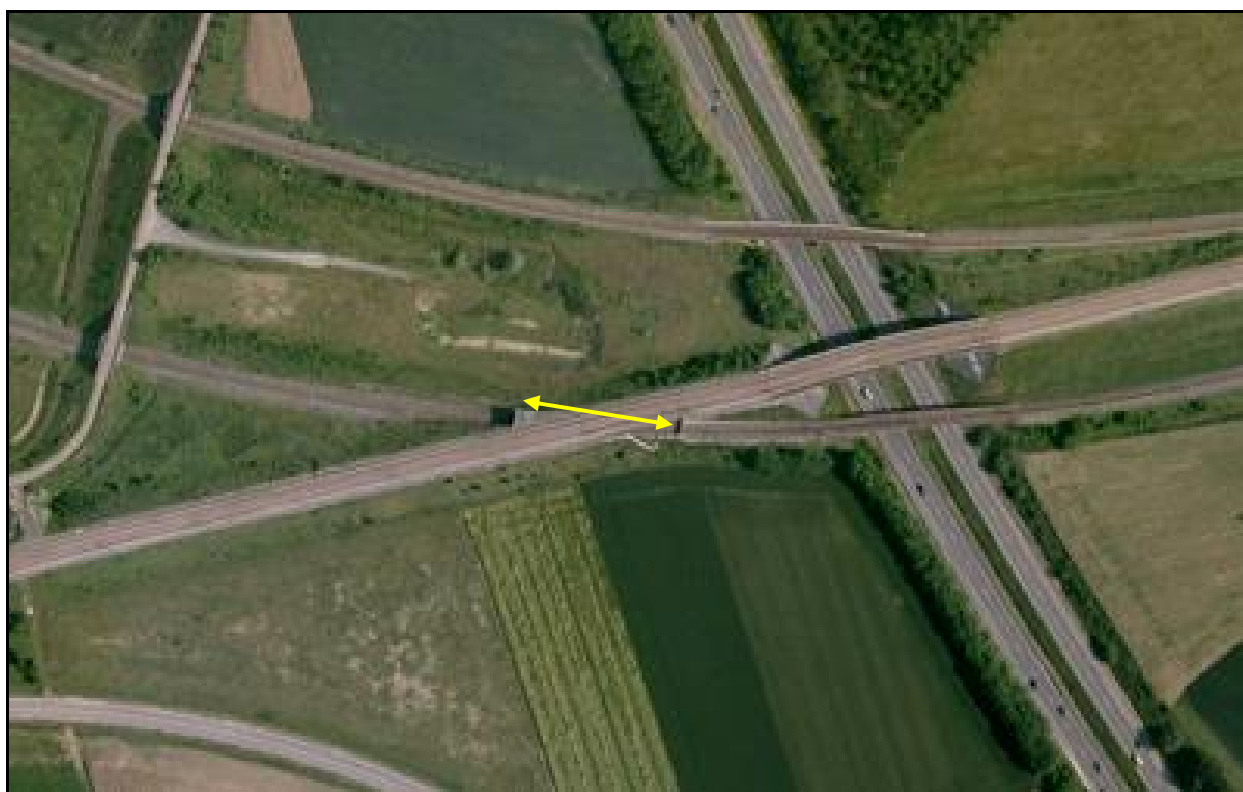
Vue aérienne de la galerie Fretin Est LGV
