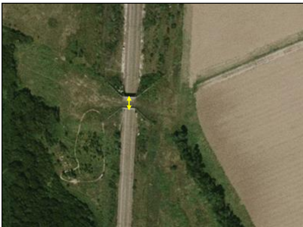
Vue aérienne de la galerie du Bois de Putinval LGV
