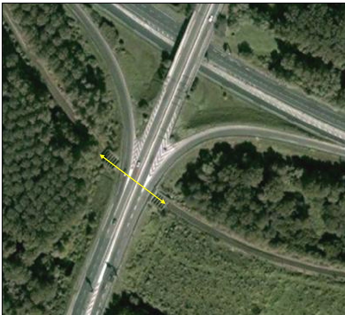
Vue aérienne de la galerie du Pont de Pierre
