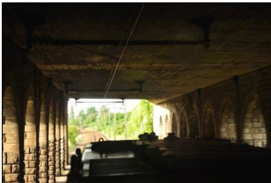
L'intérieur de la galerie
