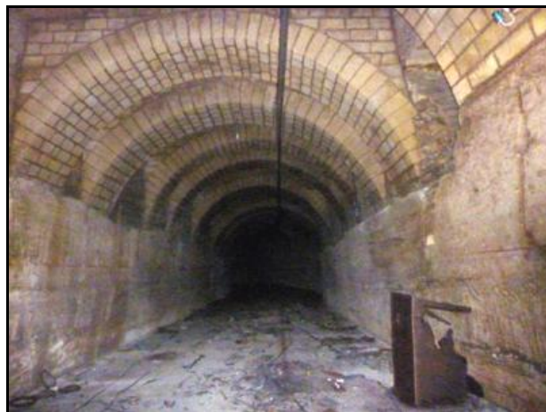
Ci-dessus et ci-dessous, divers aspects de la belle galerie de droite avec ses arcades de renfort En noir sous la voûte, l'ancienne gaine d'aération souple
