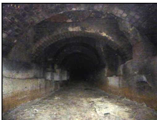
Ci-dessus et ci-dessous, divers aspects de la galerie commune, de l'entrée à la bifurcation souterraine Au plafond, dans l'axe de la galerie, la trace de fumée des locomotives à vapeur
