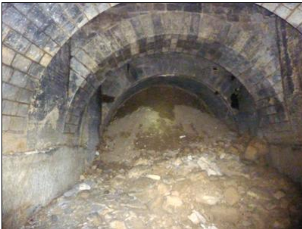
Le bouchon qui ferme la galerie gauche et empêche l'accès direct à la carrière Fèvre située derrière
