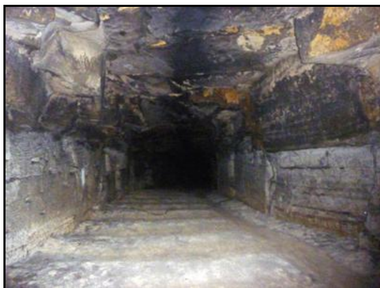
Ci-dessus et ci-dessous, divers aspects de la galerie commune, de l'entrée à la bifurcation souterraine Au plafond, dans l'axe de la galerie, la trace de fumée des locomotives à vapeur
