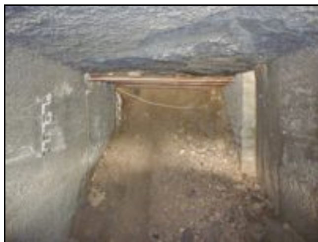
Ci-dessous, l'intérieur de la galerie avec le bouchon de déblais qui l'obstrue
