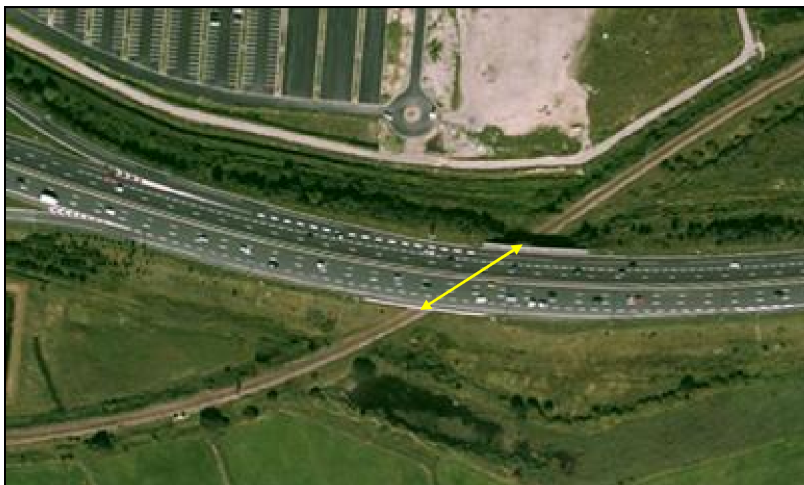
Vue aérienne de la galerie sous l'autoroute
