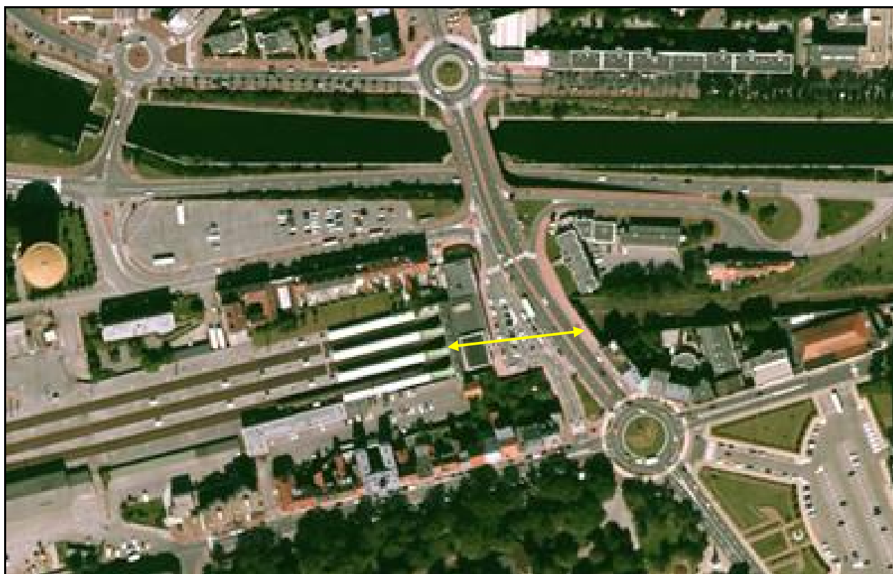
Vue aérienne de la galerie de la Gare
