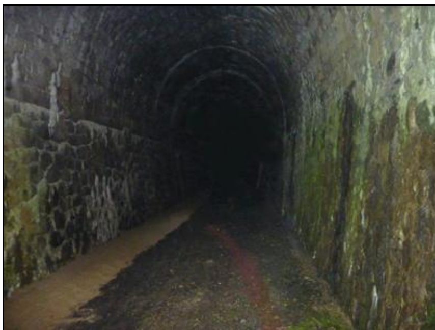
L'intérieur du tunnel
