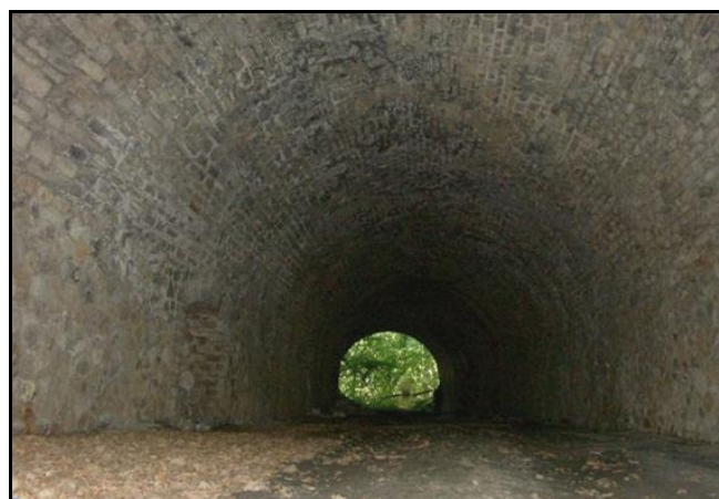
Ci-dessus et ci-dessous, la galerie du tunnel et le lâchage de piédroit
