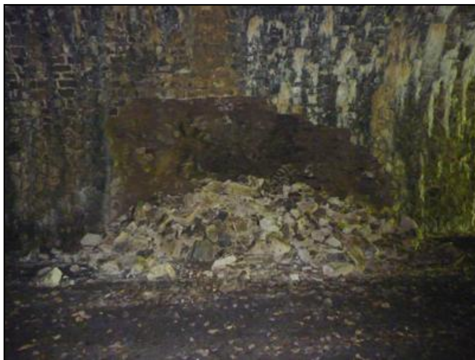
Ci-dessus et ci-dessous, la galerie du tunnel et le lâchage de piédroit
