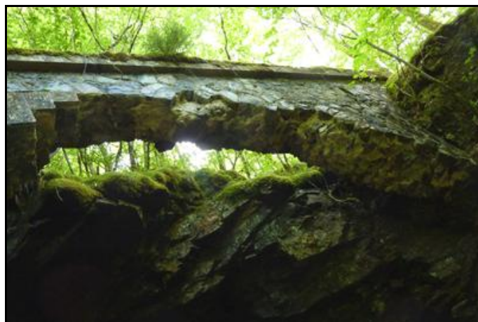
Détail du fronton complètement décollé de l'entrée
