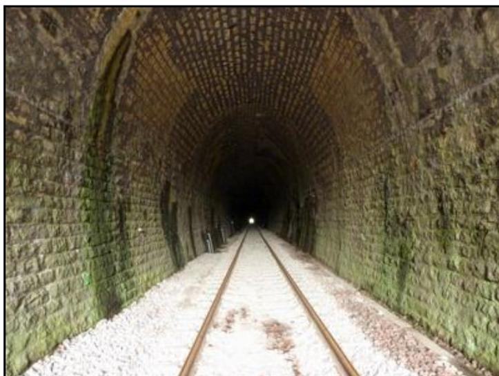
Ci-dessus et ci-dessous, la galerie recoupe de nombreuses infiltrations captées avec des drains muraux
