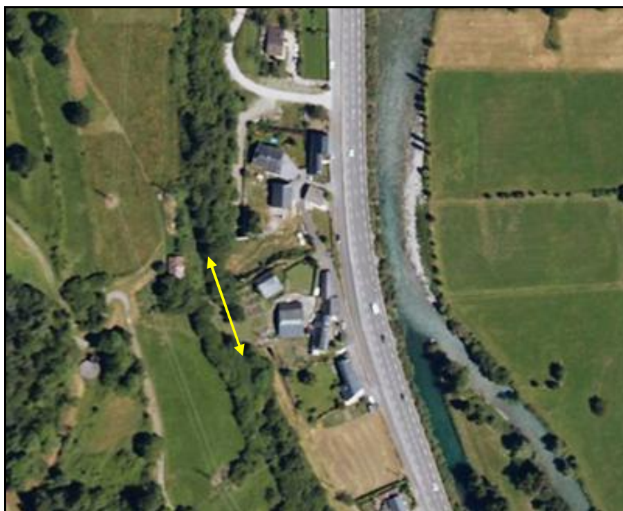
Vue aérienne du faux tunnel de Geteu
