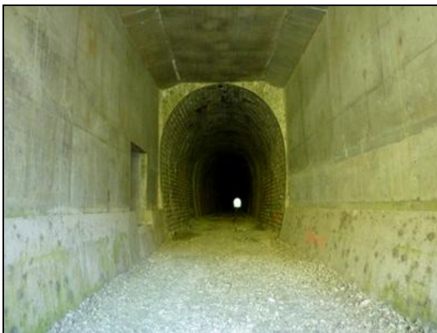
La jonction entre le pont routier et l'ancien fronton d'entrée du tunnel
