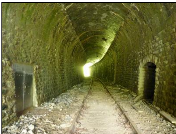
Ci-dessus et ci-dessous, une porte qui protège un captage d'eau
