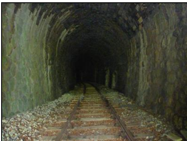
Deux aspects de la galerie : avec et sans parement
