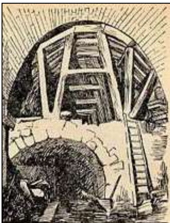
Ci-dessus et ci-dessous, construction et coupe de la galerie dans sa partie sans péroits ajourés
