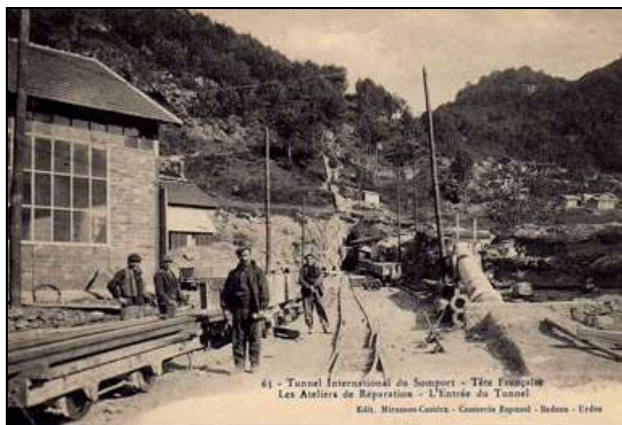
Ci-contre, l'entrée du tunnel à l'époque des travaux
