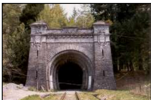
Ci-contre, l'entrée du tunnel peu de temps avant qu'elle ne soit aménagée en galerie de secours pour le tunnel routier
