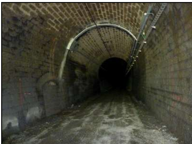
Ci-dessus et ci-dessous, divers aspects de la galerie aménagée en issue de secours pour le tunnel routier
