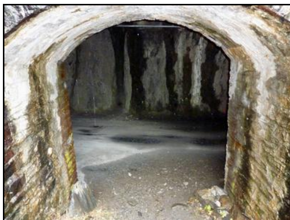
La fenêtre vue depuis l'extérieur
