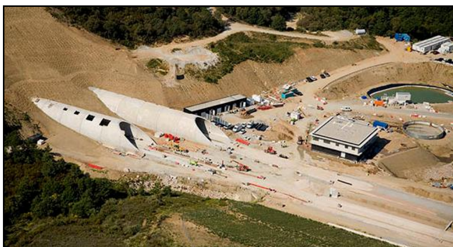
Au premier plan, le tube est ; et au second, le tube ouest
