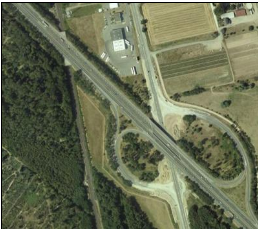
Vue aérienne de la galerie sous l'autoroute A 4
