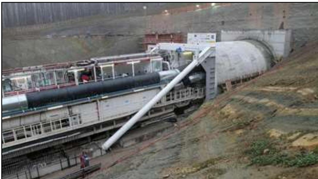
Cette photo montre le cadre métallique et ses jambages, appel bâti de poussée, sur lequel le tunnelier prend appui au départ, avant pose des premiers anneaux de voussoirs. Par la suite, le tunnelier prend directement appui sur la tranche des voussoirs pour avancer.
