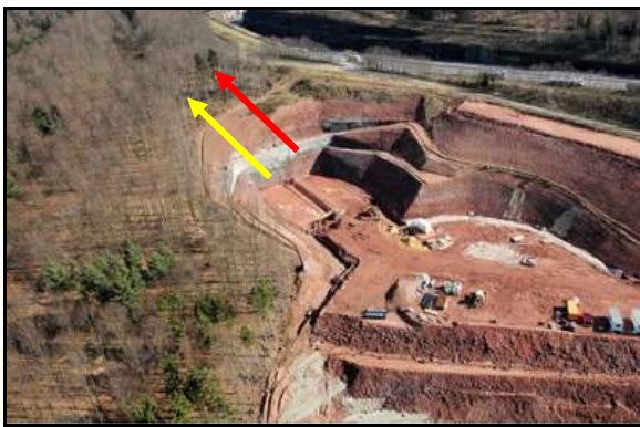
Deux vues générales du chantier alsacien, côté sorties des tubes Sur la photo de gauche : la flèche jaune représente le tube Sud, la flèche rouge le tube Nord Sur la photo de droite au premier plan, le stockage des voussoirs qui constitueront les parois des galeries
