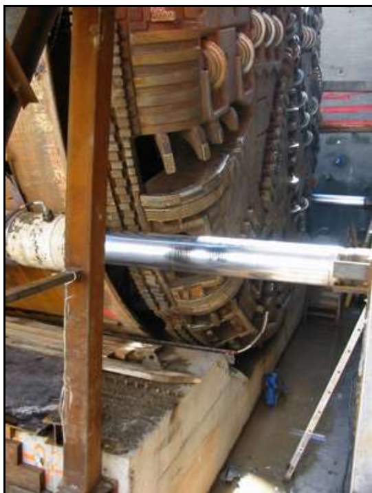
Deux gros plans sur le tunnel en position d'attaque pour creuser le tube sud
