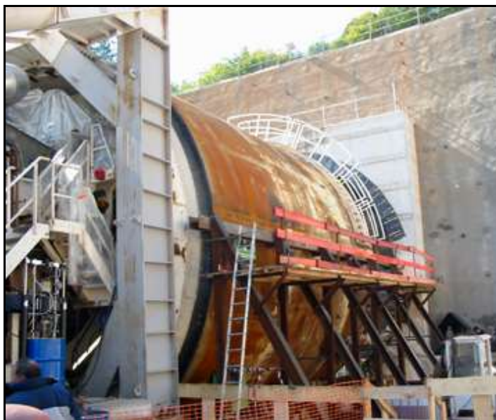
Deux gros plans sur le tunnel en position d'attaque pour creuser le tube sud
