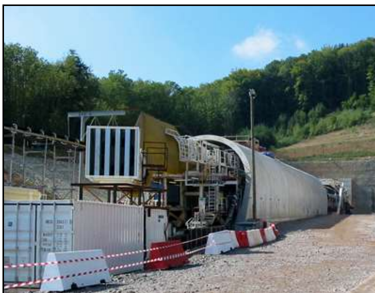
Au premier plan, le faux tunnel en béton qui constituera le portail d'entrée du tunnel Le tunnelier dont on voit l'arrière est engagé dedans
