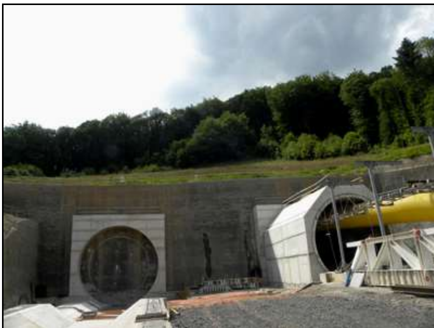
Le tube Nord, ici à droite, est en cours de creusement
