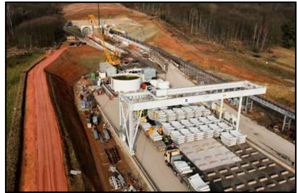
Deux vues générales du chantier alsacien, côté sorties des tubes Sur la photo de gauche : la flèche jaune représente le tube Sud, la flèche rouge le tube Nord Sur la photo de droite au premier plan, le stockage des voussoirs qui constitueront les parois des galeries
