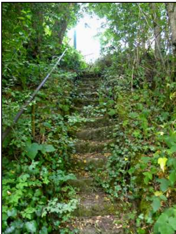
L'escalier dans sa partie supérieure perpendiculaire au talus
