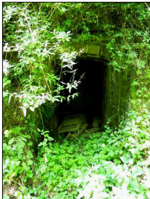
La chambre souterraine sous la partie basse de l'escalier
