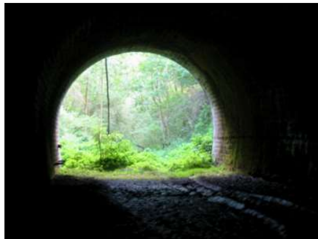
La sortie vue de l'intérieur
