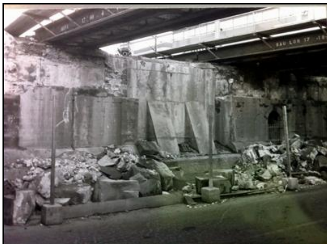
La destruction et l'élargissement de l'ancien ouvrage Les voies de la gare de Strasbourg sont supportées par un nouveau tablier
