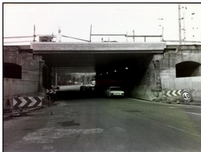
La destruction et l'élargissement de l'ancien ouvrage Les voies de la gare de Strasbourg sont supportées par un nouveau tablier
