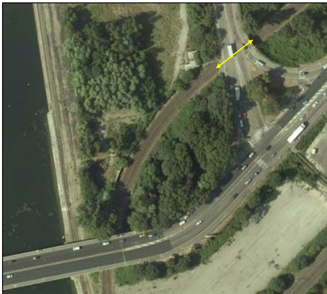
Vue aérienne de la galerie de la route du Petit Rhin
