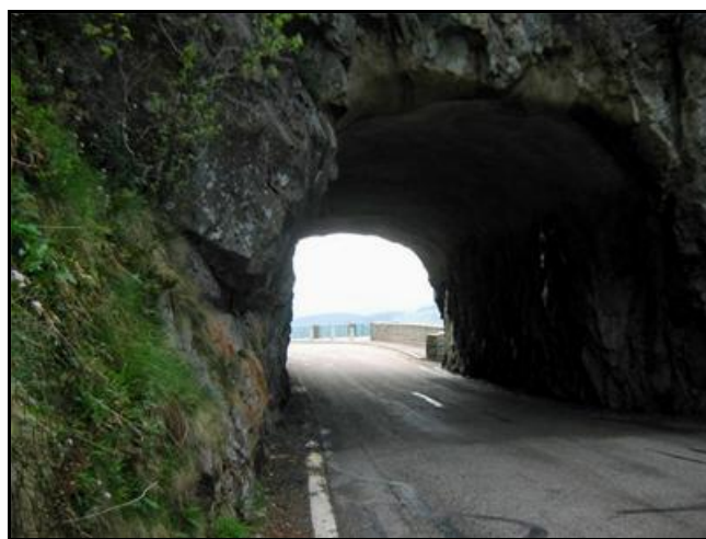
La galerie du tunnel de Krappenfels
