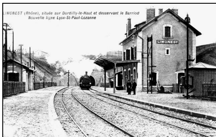
L'entrée du tunnel et la gare de Limonest du temps de la vapeur
